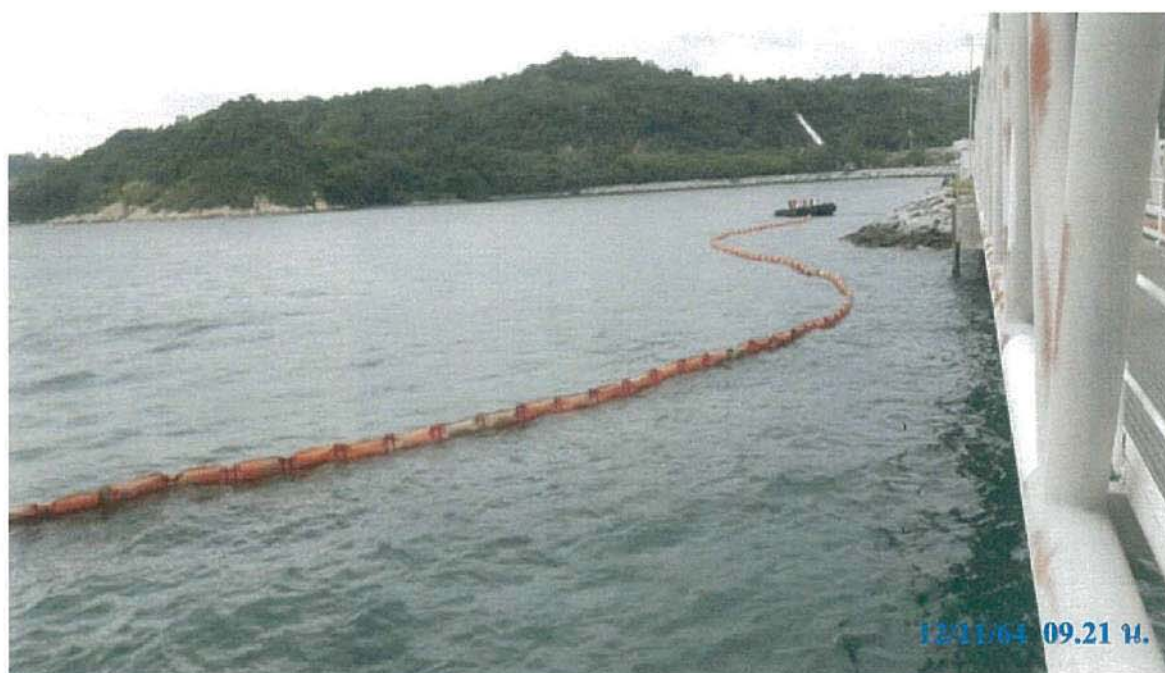
STT 4 ภาพแสดงเรือรับเชือกลาก BOOM ไปล้อมคราบน้ำมันตามคำสั่ง หัวหน้ากะ
