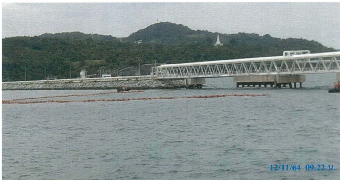
STT 5 ภาพแสดงเรือรับเชือกจัดตำแหน่งล๊อม BOOM เพื่อเก็บล๊อมคราบน้ำมัน
