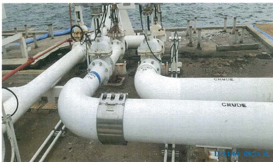
STT 10 ภาพแสดง Camp ขนาด 12 นิ้ว ที่รัศบริเวณจุดที่น้ำมันที่รั่วไหล เพื่อหยุดการรั่วไหลของน้ำมัน
