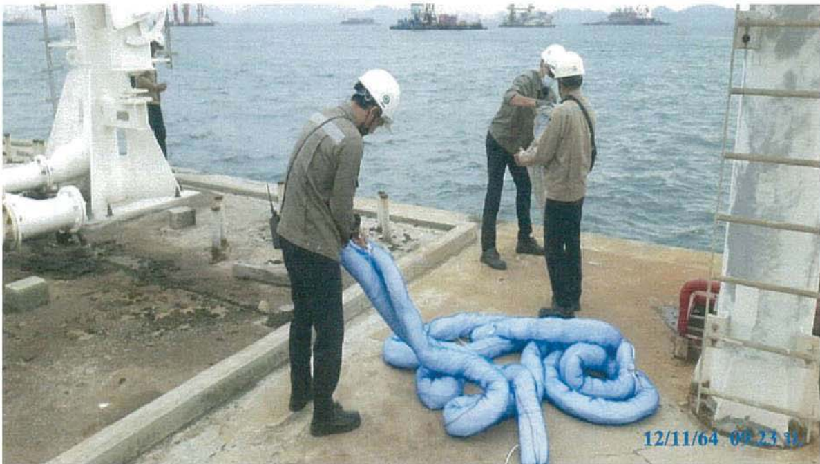
STT 7 ทีม OP ปฏิบัติการหน้าท่า ได้นำ Oil sorbent boom ไปล้อมคราบน้ำมันนอกแนวปูน Loading Plate Form
